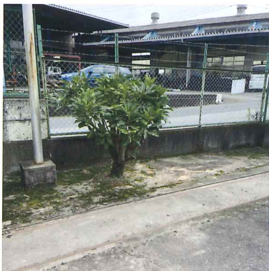
12年前施工 植樹回り ソイル40m/m
