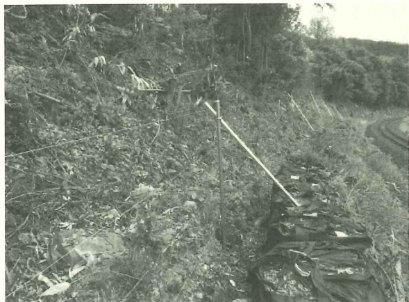
写真-3 鹿侵入防止柵(石北線96k000m付近)
