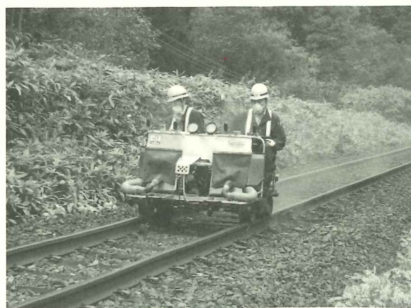
写真-1 施行中のレールカート式レール研磨機
