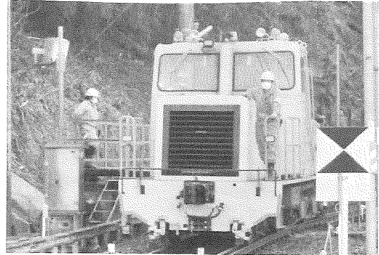
図-16 軌道作業車(MC)による試験走行
