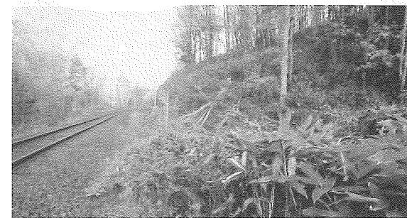
図-12 沿線樹木伐採後
